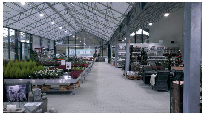
FL100 Sunlight-Installation in einem Gartencenter in Norwegen
